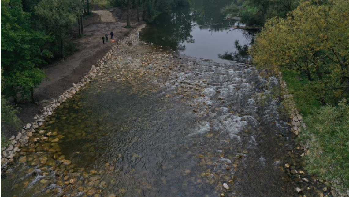
Fertiggestellte Ampergleite bei Inkofen (Bild: Wasserwirtschaftsamt München)
