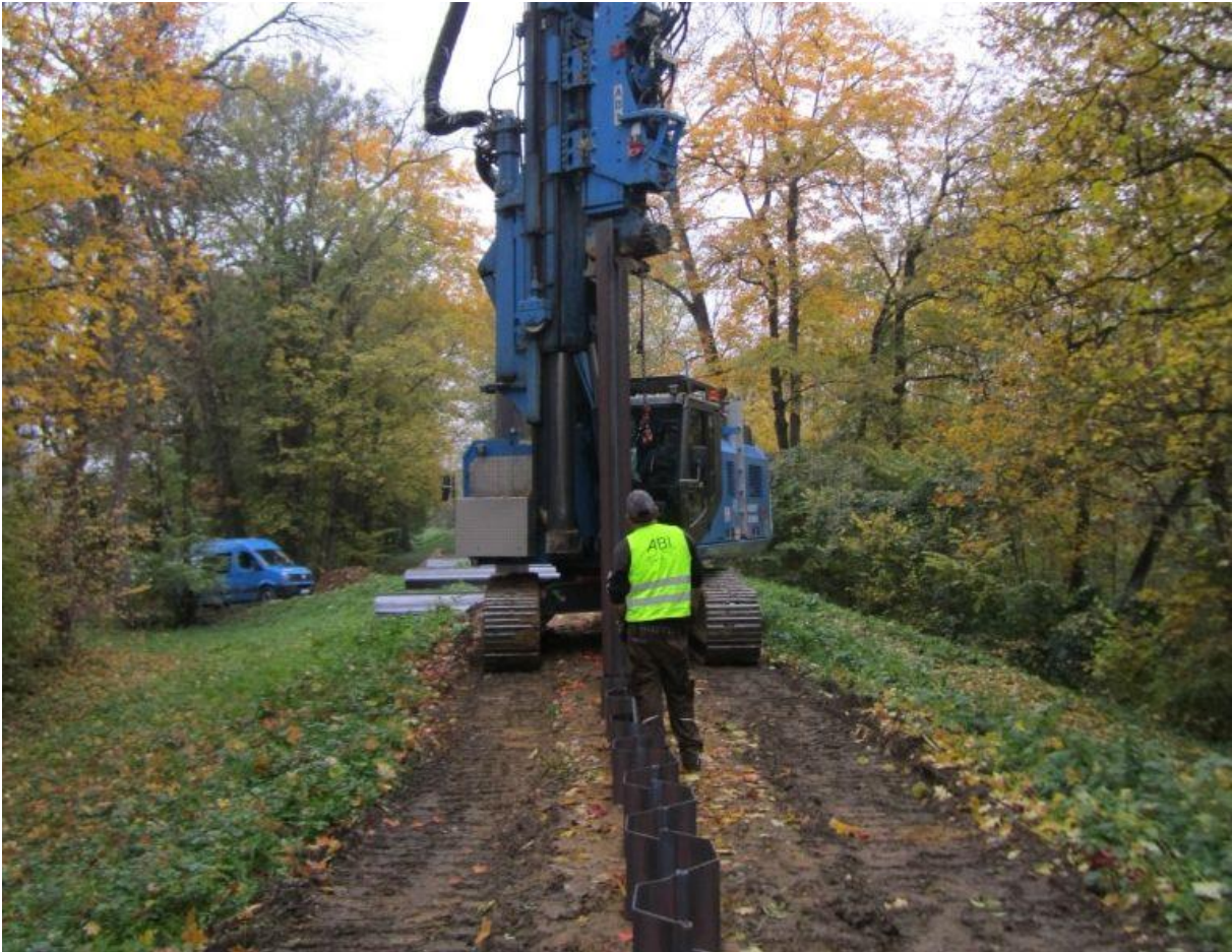
Einbringen einer Spundwand in einen bestehenden Hochwasserschutzdeich (Bild: WWA München)
