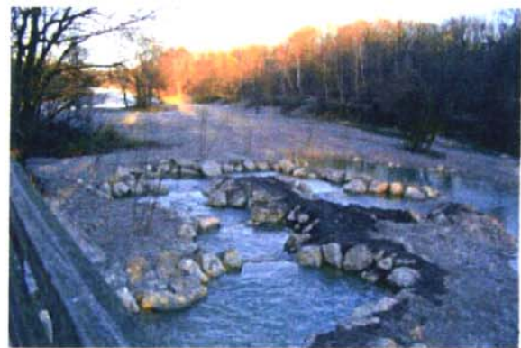
写真-6 施工後の落差工 緩やかな落差により魚が移動しやすくなっている
