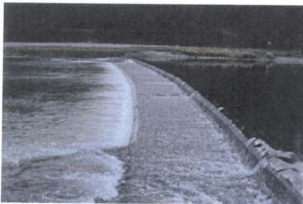
写真-9 施工前の落差工
