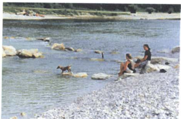
写真-10 施工後の落差工 市民が憩える場所 になっている
