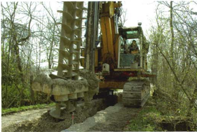
Abb. 9: Einbau der Dichtwand im Mixed-in-Place-Verfahren in alte Deiche
