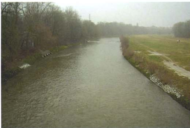
Abb. 7: Kanalartiger Ausbau des Gewässerbettes der Isar im innerstädtischen Raum („vorher“)
